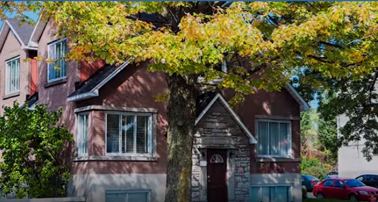
La Maison Kangourou avant le dégât d'eau 2018
